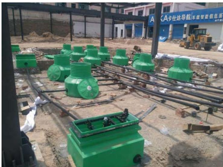
优捷特YMC系列承重复合井盖是使用整体性，高承载力的片状纤维增强型树脂材料（简称“SMC”），通过大吨位液压设备，采用模压工艺，经过高温高压一次成型，具有非金属、高强度、耐磨损的特性，能够完全满足加油站井盖的独特技术要求。井盖通常配合井座和井环一起使用。
