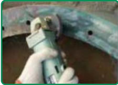
油罐法兰如有铁锈油污等异物必须清理干净，干燥后涂胶。
