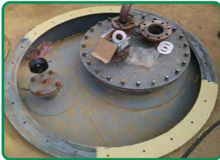
法兰不平超6mm油罐厂家处理，法兰不平6mm以内修补方法：原子灰找平
